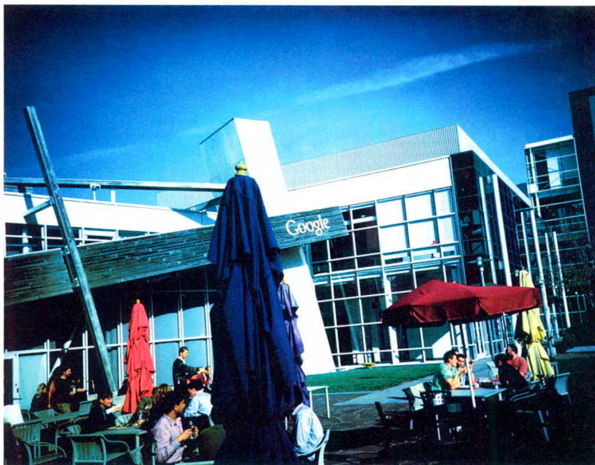
Solar. Las oficinas de Google tienen paneles solares capaces de dar energía a la mitad de San Francisco.
